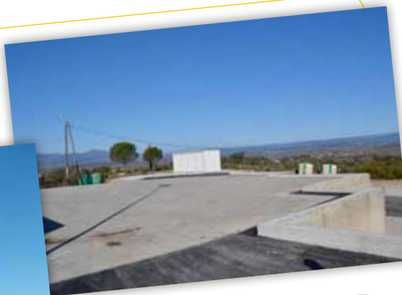
Travaux sur la déchetterie de Beaulieu
