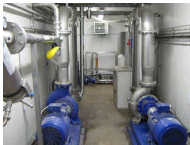
Les 2 lignes d'ultrafiltration
