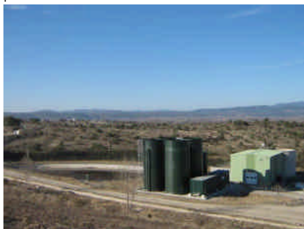
Vue sur la nouvelle installation (couleur vert sapin)
