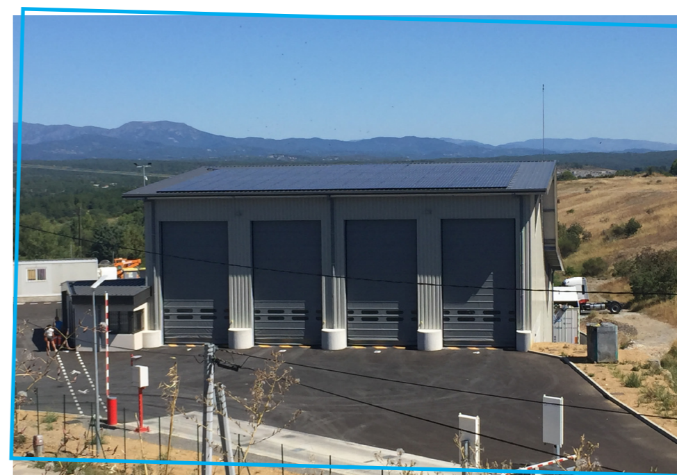
Le quai de transfert avec sa toiture photovoltaïque
