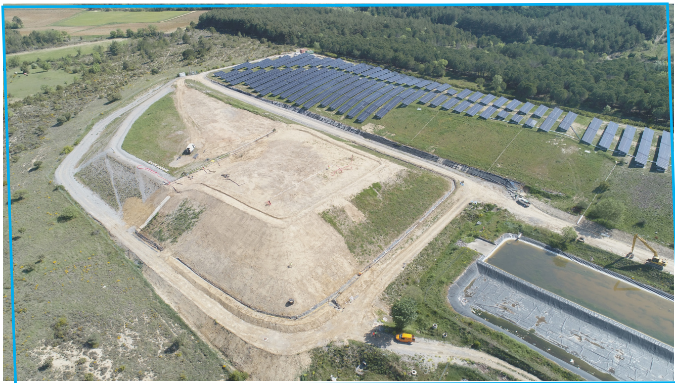
Vue sur le casier 5 réhabilité et le parc photovoltaïque
