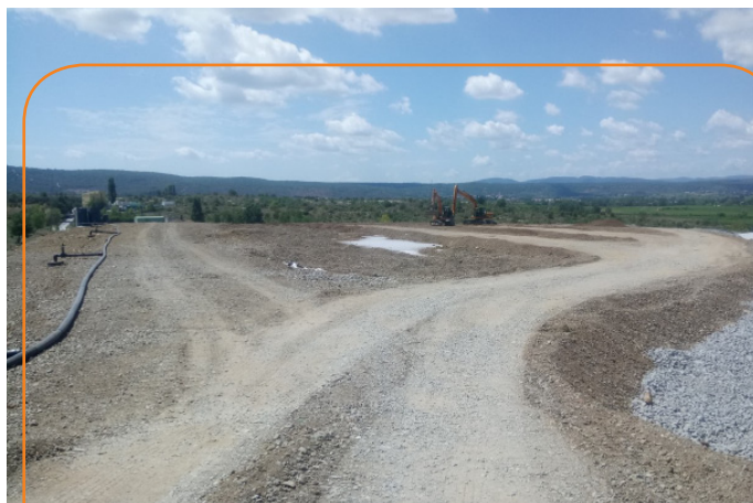
Mise en place de la couverture finale sur le dôme
