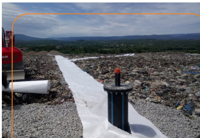
Drains et cheminées pour le captage du biogaz
