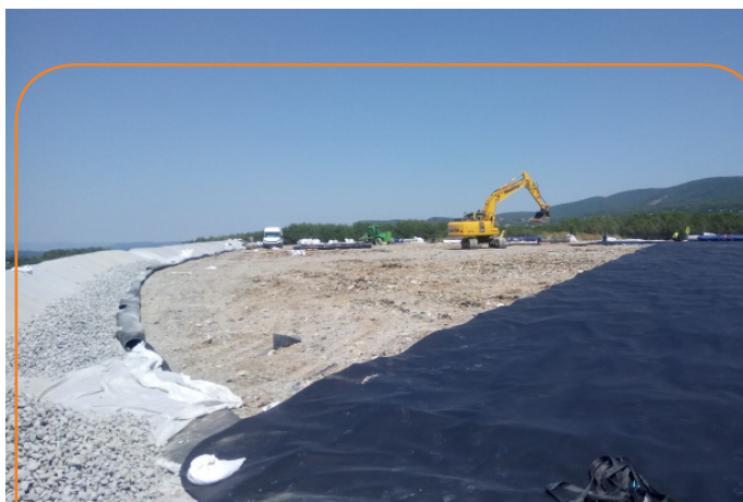
Mise en place de la bâche d'étanchéité sur le dôme
