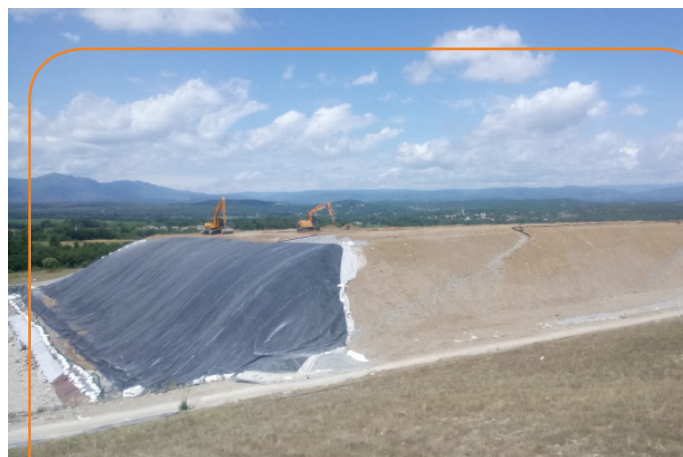
Vue des alvéoles 2 et 3 réhabilitées
