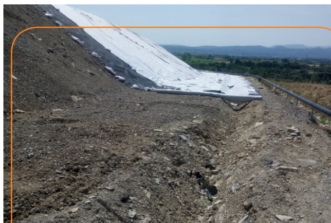
Mise en place de l'étanchéité sur les talus
